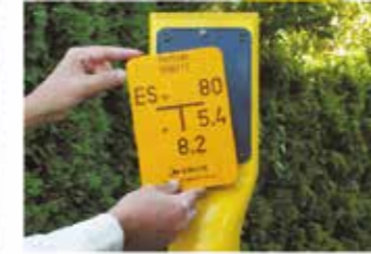
Aufschnappen des FP-Hinweisschildes Snapping in the FP indicator sign
